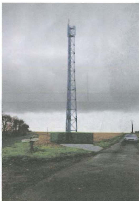
Vue Proche 1 : Après les travaux
